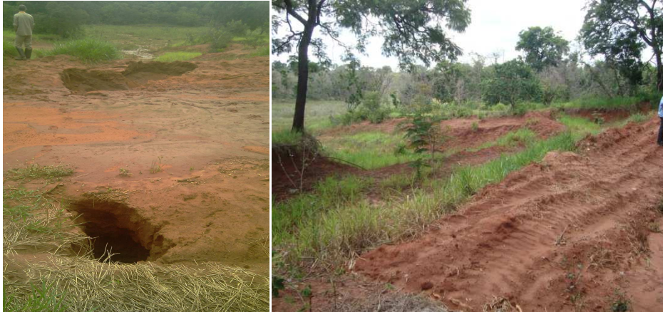
Fotos 34 e 35: Erosão em estrada e ações corretivas
